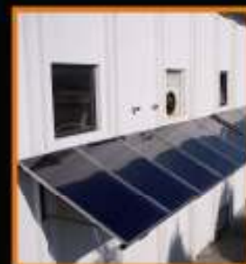
Treviso (PG): impianto solare termico con installazione a parete per Industria trattamenti galvanici
