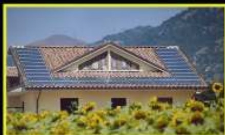
Loc. Padule - Gubbio (PG): impianto fotovoltaico a tetto ad integrazione totale per abitazione privata.
