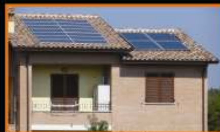
Castelvieto (PG): abitazione autosufficiente con impianto fotovoltaico e solare termico ad integrazione totale
